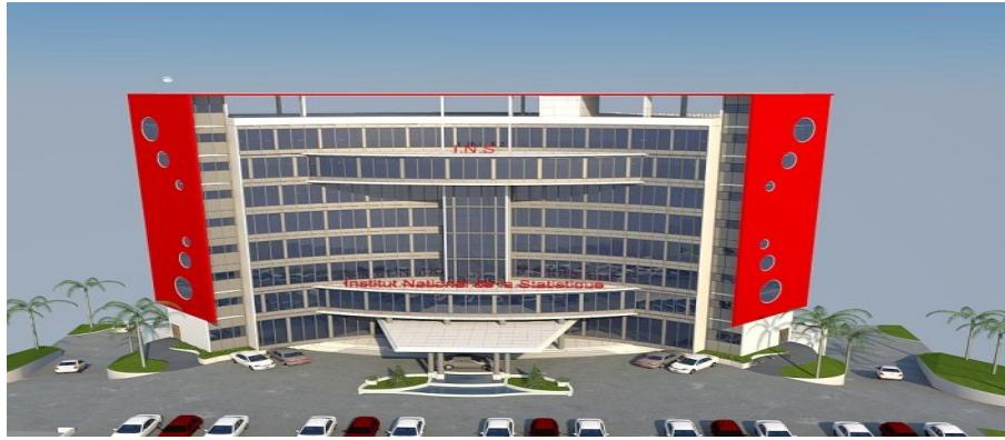
Vue de face en profil de l'immeuble siège de l'INS (en cours de construction)
